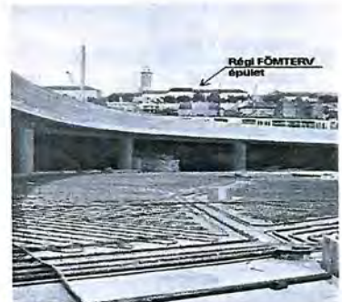
Burkolatba épített fűtőcsövek a Magyar Jakobinusok terén lévő gyalogos aluljáróban
