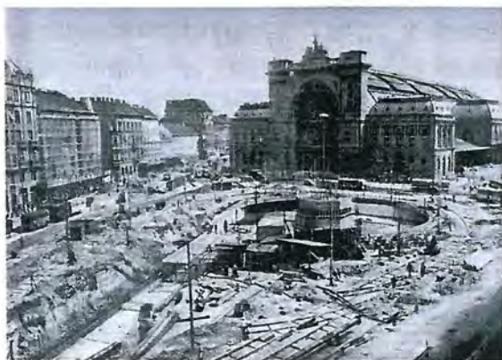
A Baross téri aluljáró építése. A központi süllyesztett tér kialakítása
