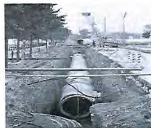
A IV. sz. főnyomócső fektetés közben
