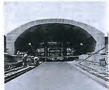
A Batthyányi téri HÉV bevezetés építés közben
