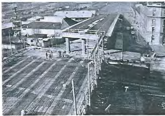
A Hungária körüli felüljáró, vasszerelés
