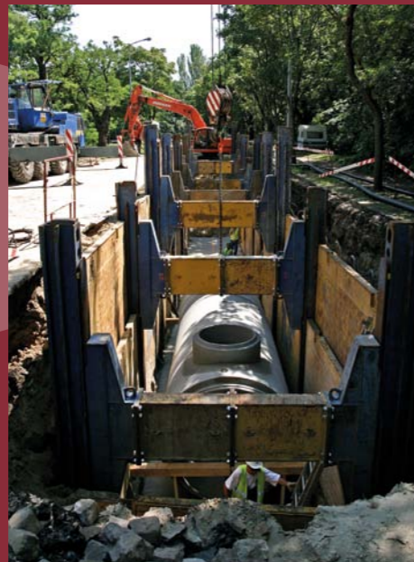
■ KINIZSI UTCA, TRENCHLESS CONSTRUCTION, 2012 ■ NÉPLIGET, SEWER MAIN, 2012
