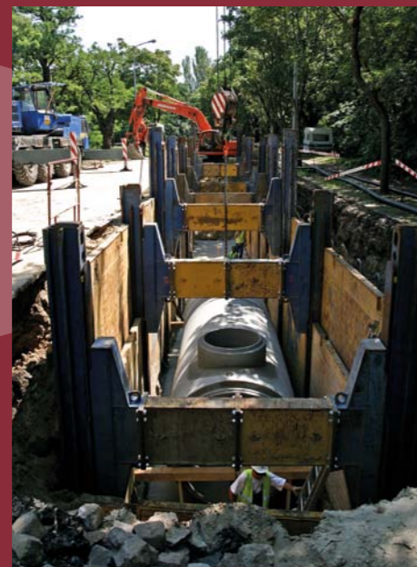
■ KINIZSI UTCA, CSATORNA SAJTOLÁS, 2012 ■ NÉPLIGET, GYŰJTŐCSATORNA, 2012
