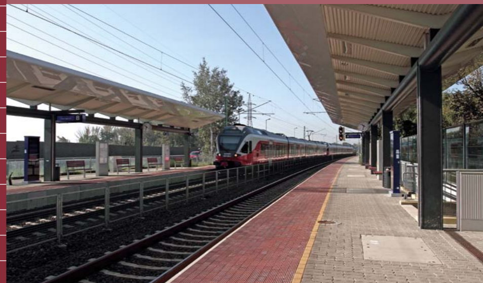
■ KELENFÖLD-TÁRNOK VASÚTVONAL, KASTÉLYPARK MEGÁLLÓHELY, 2013
