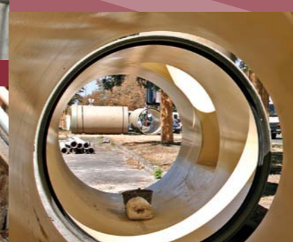
■ 4-ES METRÓ SZELLŐZÉS, 2014 ■ RÓNA UTCA, CSATORNA ÉPÍTÉS, 2012
