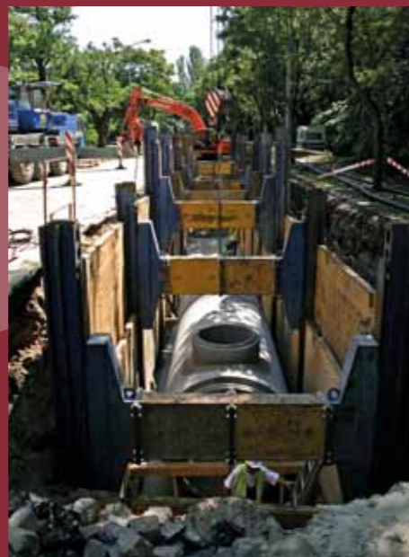
■ УЛ. КИНИЖИ, СТРОИТЕЛЬСТВО КАНАЛИЗАЦИИ, 2012 ■ НЕПЛИГЕТ, СТОКОВАЯ КАНАЛИЗАЦИОННАЯ ТРУБА, 2012
