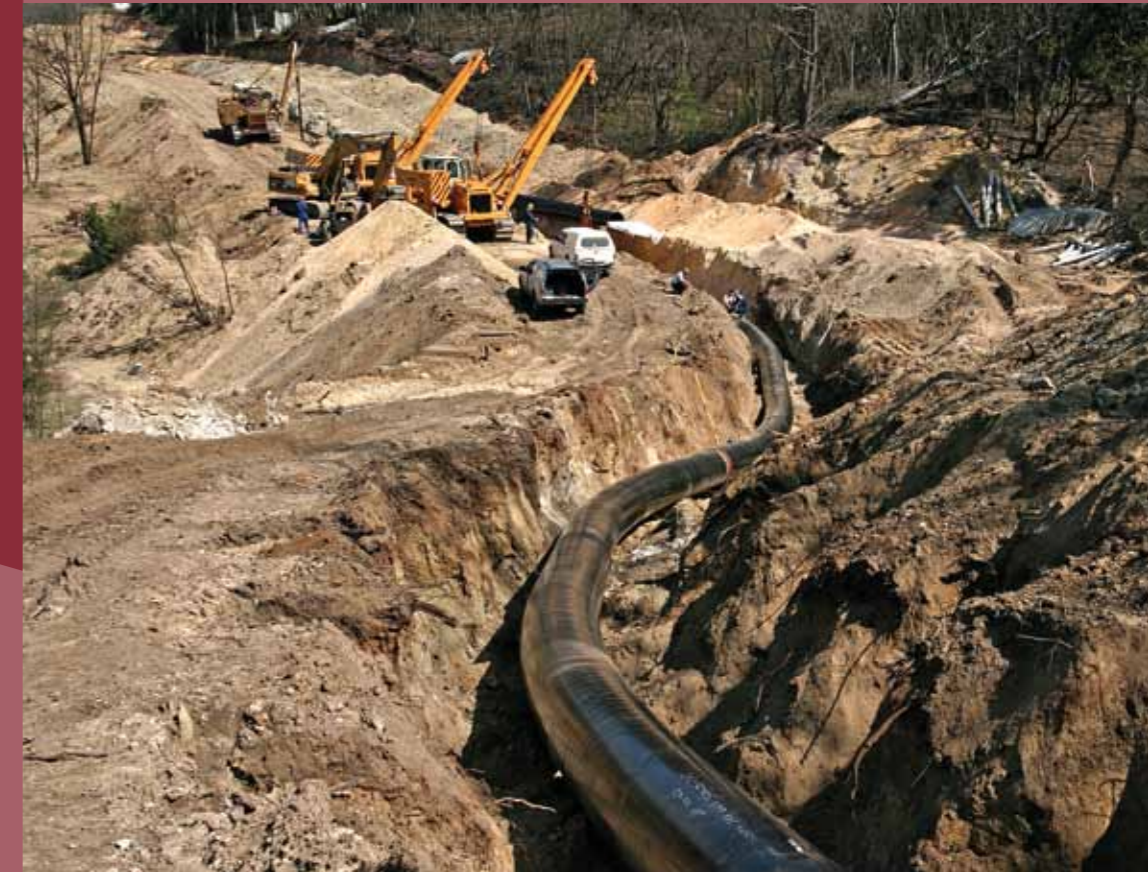
■ ПИЛИШЧАБА, СТРОИТЕЛЬСТВО ГАЗОПРОВОДА, 2008
