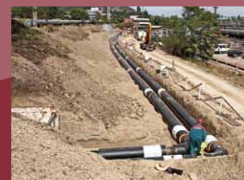
■ ЕРМЭЗЭ, СТРОИТЕЛЬСТВО ДИСТАНЦИОННОГО ОТОПЛЕНИЯ, 2013
