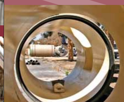
■ ВЕНТИЛЯЦИЯ 4-ОЙ ЛИНИИ МЕТРО, 2014 ■ УЛ. РОНА, СТРОИТЕЛЬСТВО КАНАЛИЗАЦИИ, 2012
