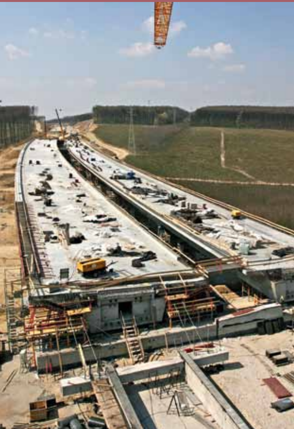
■ МОСТ ШИБРИК МИКЛОШ, 2014 ■ АВТОСТРАДА М7, МОСТ S70, 2008
