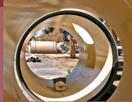
■ أعمال التهوية في المترو (4) 2014 م ■ أعمال بناء القنوات في شارع رونا (Róna utca) - 2012 م
