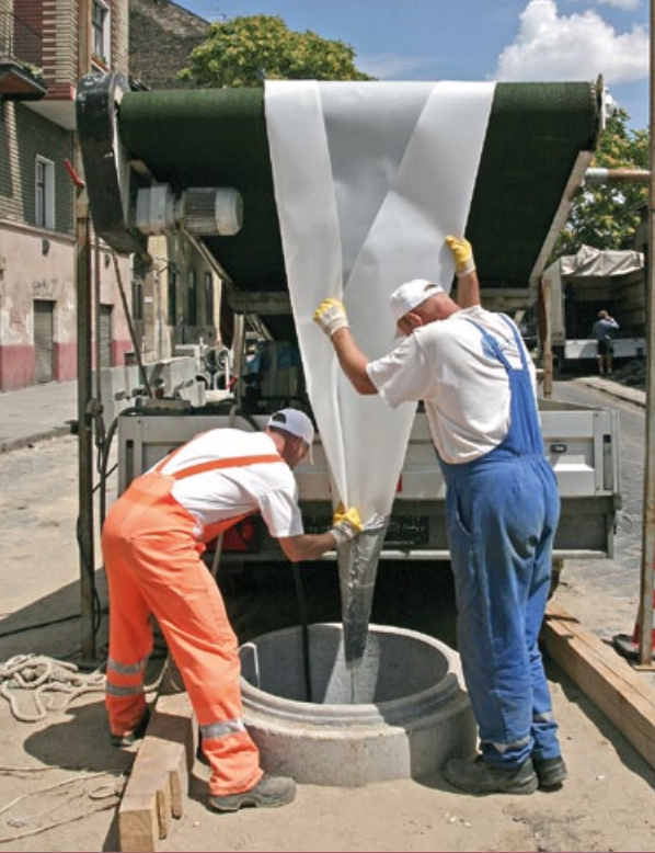
■ أعمال تبطين قنوات الصرف الصحي في شارع فرشنبي (Verseny utca) - 2007م
